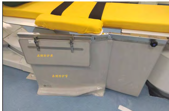
床侧防护屏、防护帘
