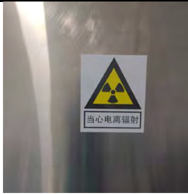
患者入口防护门外电离辐射标志和中文警示说明
